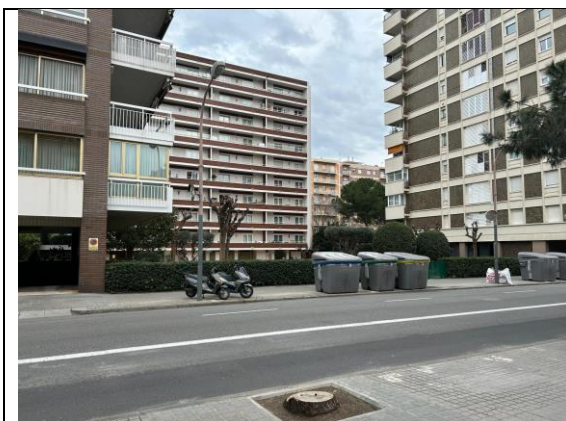
Foto dels contenidors objecte de la queixa i de les terrasses de la finca afectada
